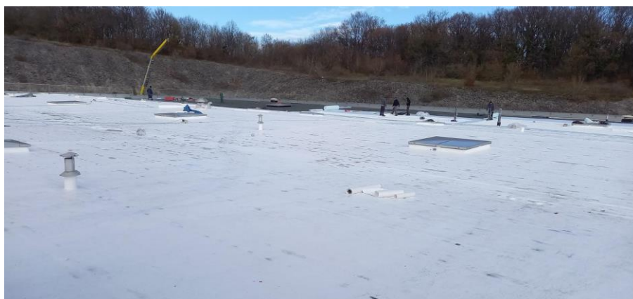
Photo de la toiture en cours de rénovation à l'ESAT de Belfort
